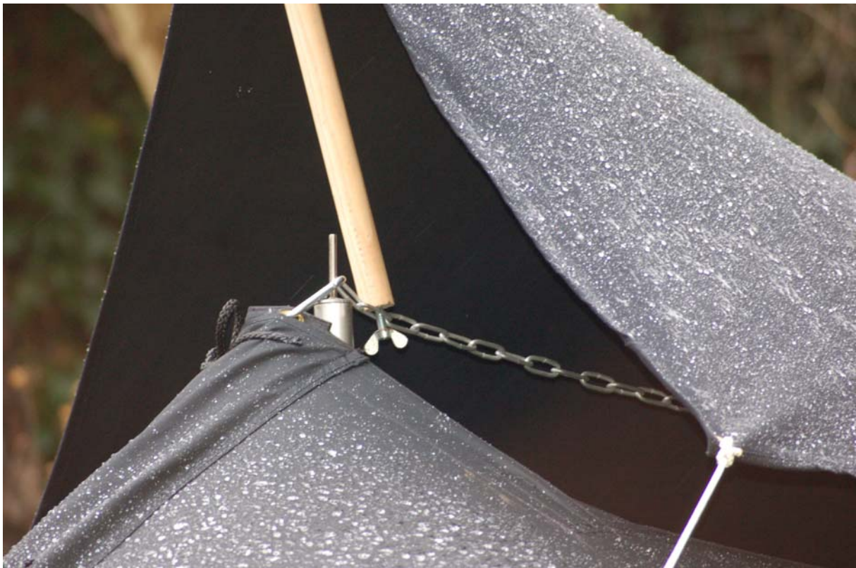
Das Rauchloch in der Größe von etwa 1m x 0,6m wird fixiert durch ein Kettenstück, in dessen Enden die Spitzen der inneren Stützstangen eingesteckt sind. Konstruktiv ist es Möglich die innere Stützkonstruktion so zu verändern das auch schwere Töpfe über das Feuer gehängt werden können.
