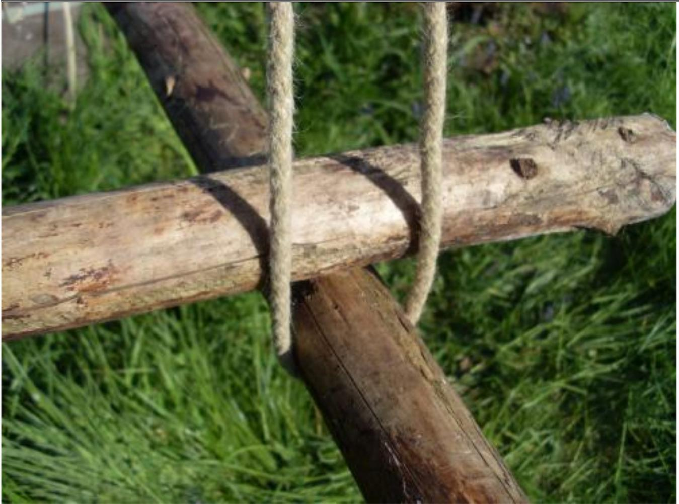
Statt das Seil mit einem Ende an einem der Hölzer fest anzuschlagen nimmst du die Mitte des Seiles, legst es an dieser Stelle unter das eine Holz und führst beide Enden nach oben. Die kommenden Bewegungen machst du sozusagen nun synchron, aber spiegelverkehrt mit der rechten und linken Hand.
